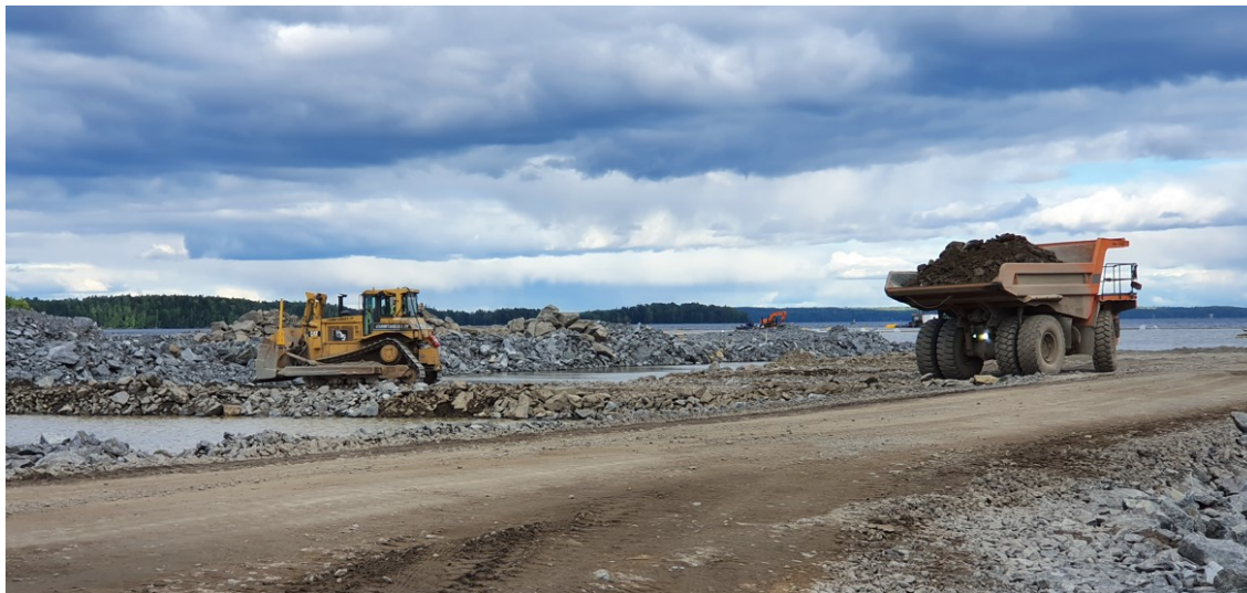
Kuva yllä. Pengerrystyö tehtiin puskemalla dumperista täytön päälle kipattu louhe veteen
