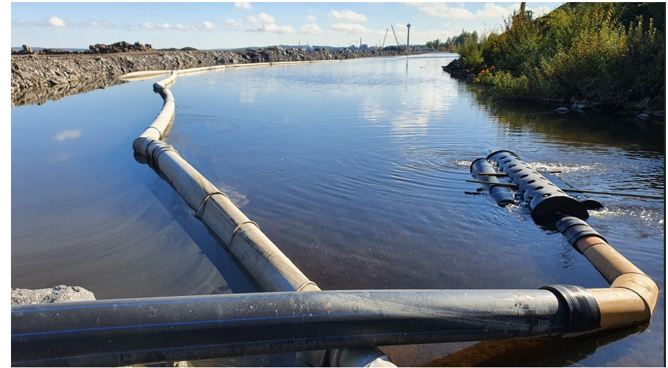
Kuva yllä. Rannan ja täytön väliseen kanavaan pumpataan puhdasta vettä veden vaihtumiseksi
