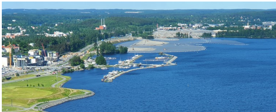
Kuva alla. Yleisnäkymä Santalahden venesatamaan ja saaren täyttötyömaalle
