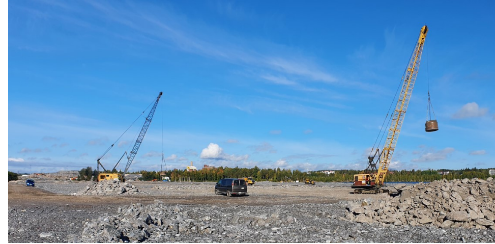
Kuva alla. Louhetäyttö tiivistettiin dynaamisesti pudotustiivistyskoneilla.
