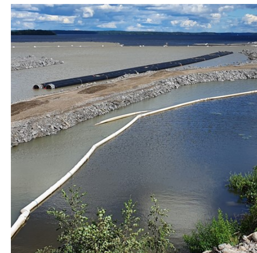
Kuva alla. Suojaverho erottaa hyvin samentuneen veden
