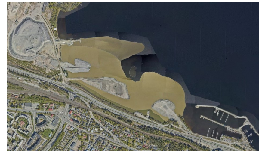
Ilmakuva yllä. Täyttötöy kesällä 2022. Suojaverho rajaa veden samenumista.
